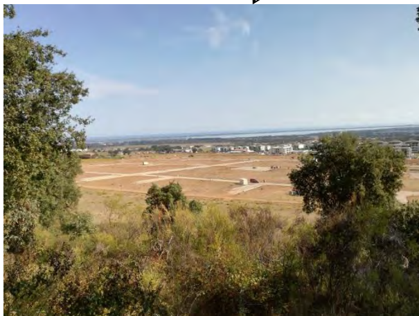
PHOTO 10 : APERÇU DES TRAVAUX ENTREE NORD
